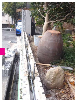
鉄筋を入れてしっかり補強します！
