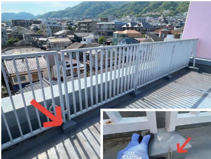
スチール製手すり
