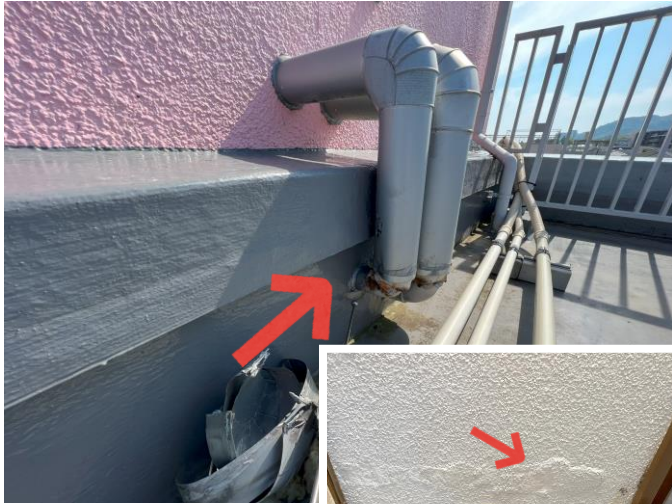
パイプの貫通部
